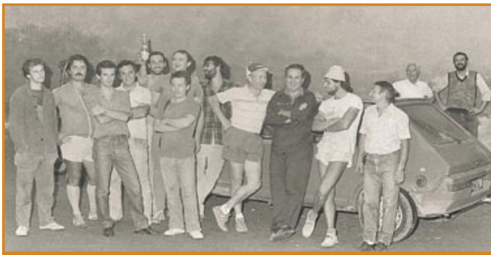
1981 - Sezione di via Terraggio Pace, "la squadra del tetto".
